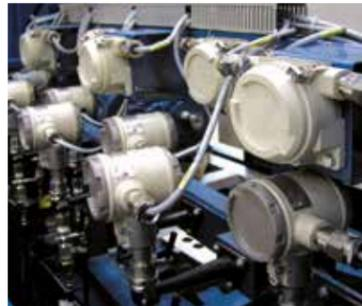
Druck- und Temperaturtransmitter zur Überwachung der Betriebsdaten eines Argon-Verdichters
