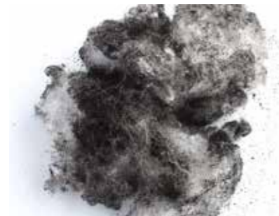
Bild 1: Ablagerungen im Schüttgut, die sich in Schalldämpfern mit Absorptionsmaterial sammeln
