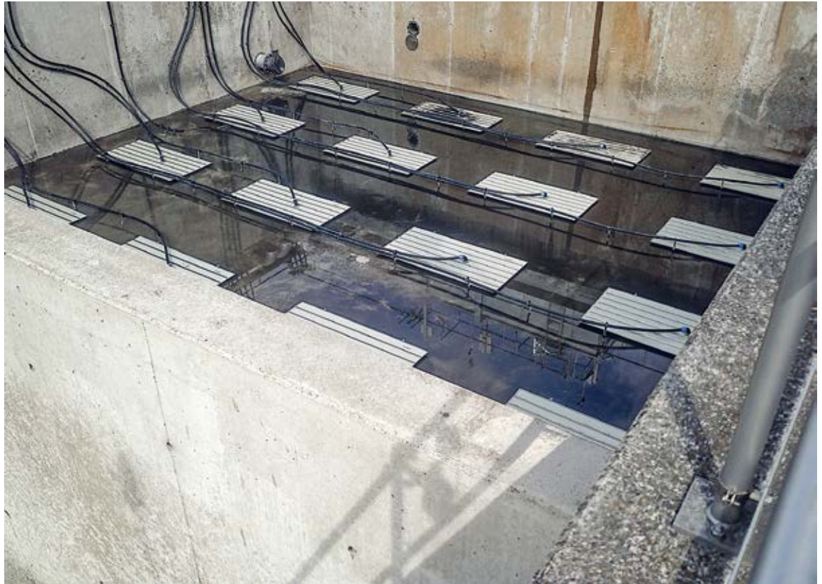
Einbau der MESSNER-Plattenbelüfter®
