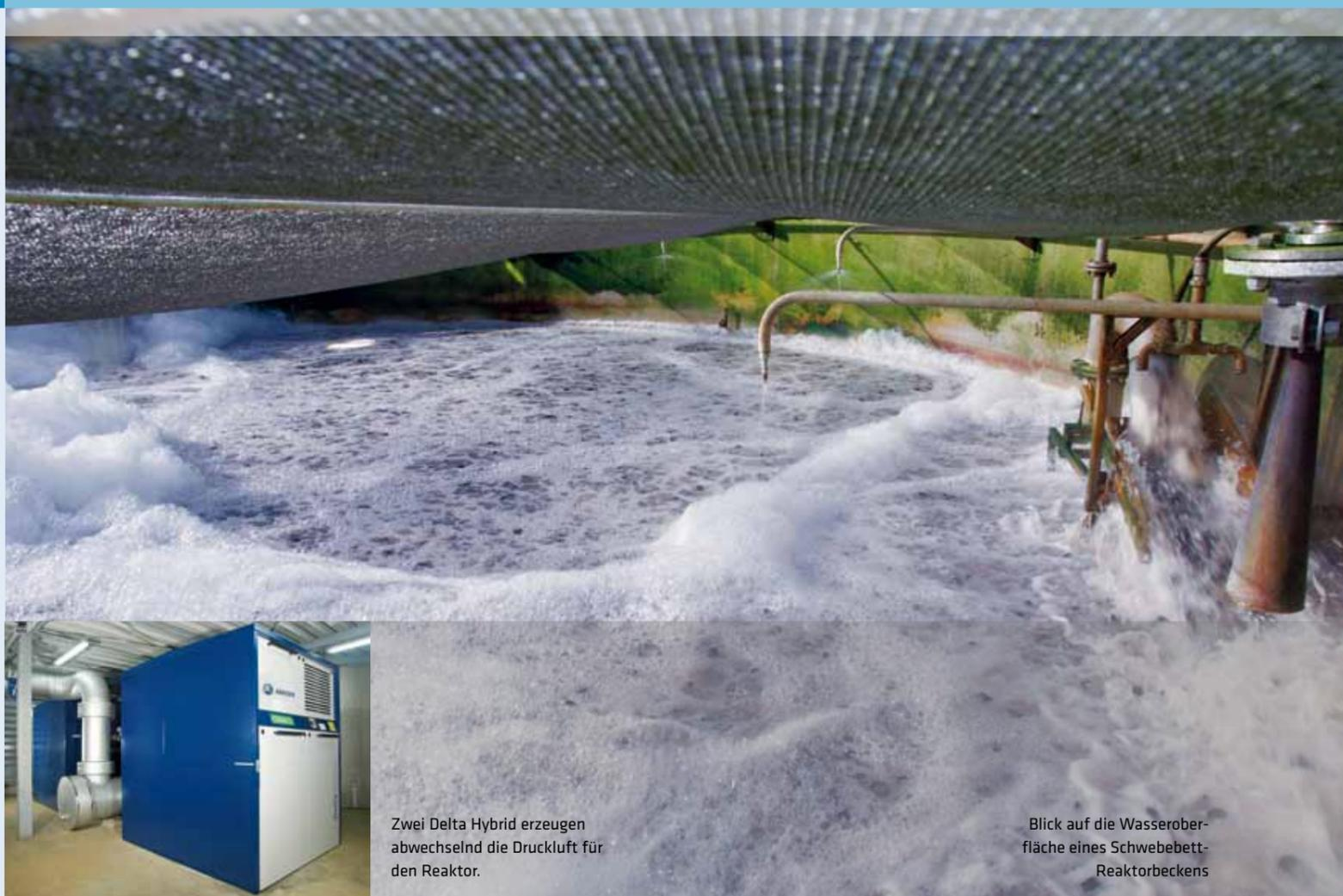
Zwei Delta Hybrid erzeugen abwechselnd die Druckluft für den Reaktor.
