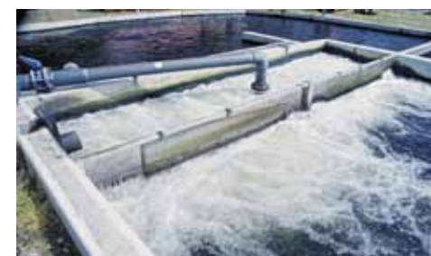
Eintrag von Sauerstoff in ein Kreislaufbecken
