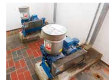
Zwei AERZEN Drehkolbengebläse belüften seit 2000 den Sandfang.
