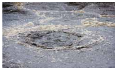
Oberfläche von Belebungsbecken 3: Deutlich sichtbar sind die Sauerstoffblasen an der Oberfläche.
