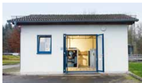
Sauerstoffstation zur Versorgung der Belebungsbecken 3 bis 6, ausgerüstet mit zwei im Jahr 2000 installierten AERZEN Drehkolbengebläsen
