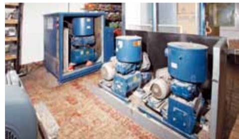
Drei AERZEN Drehkolbengebläse mit teildemontierter Schalldämmhaube in einem Nachbarraum
