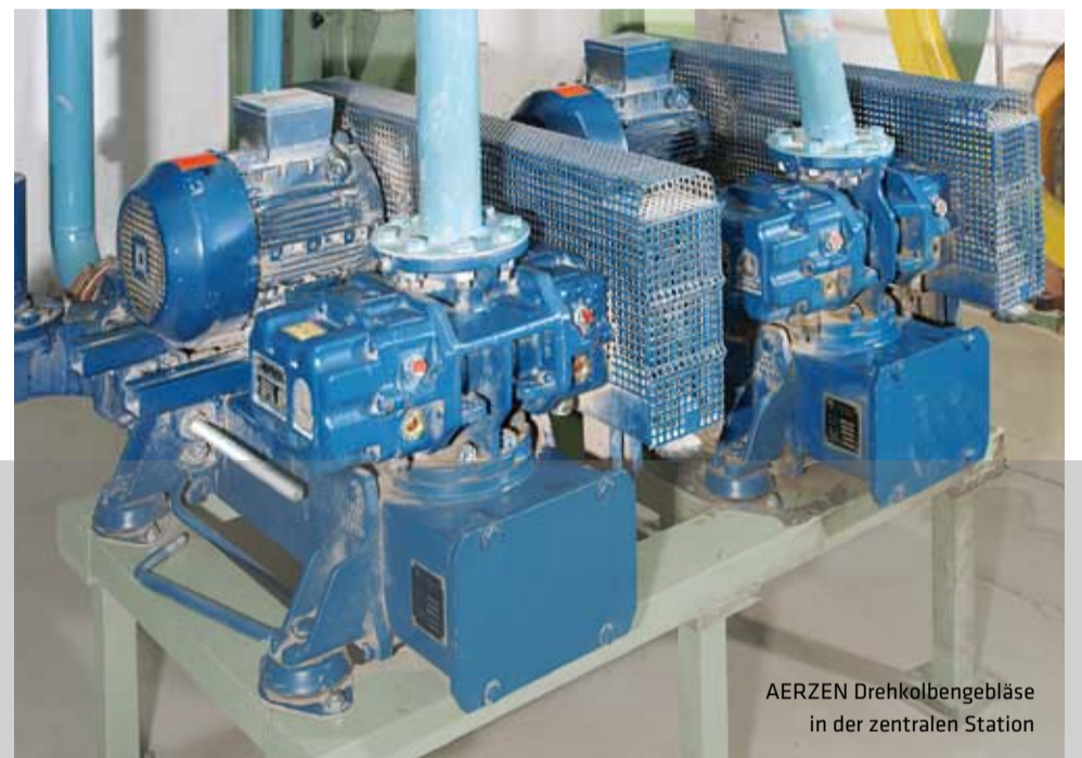
Drei AERZEN Drehkolbengebläse mit teildemontierter Schalldämmhaube in einem Nachbarraum
