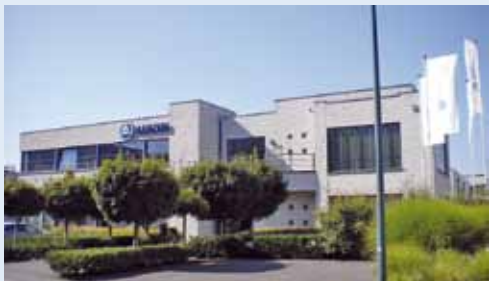
Die Zentrale von Aerzen Belgien in der Nähe von Brüssel
