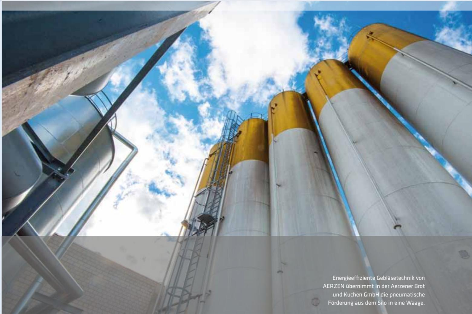
Energieeffiziente Gebläsetechnik von AERZEN übernimmt in der Aerzener Brot und Kuchen GmbH die pneumatische Förderung aus dem Silo in eine Waage.
