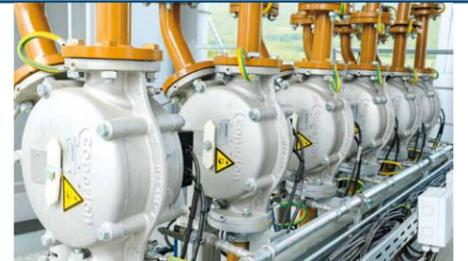
Der Braunkohlestaub wird von Delta Blowern von AERZEN durch Brennerlansen hindurch in den Brennofen geblasen.
