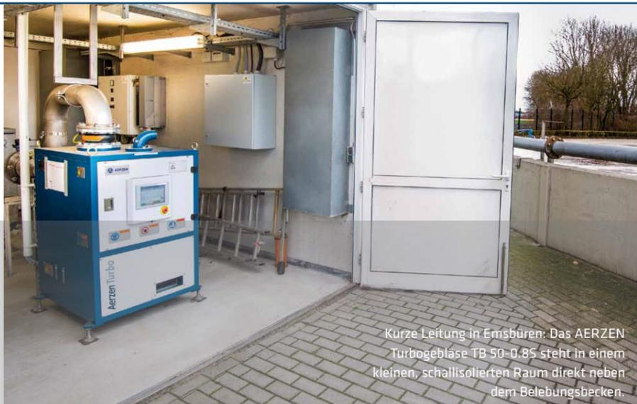
Kurze Leitung in Emsbüren: Das AERZEN Turbogebläse TB 50-0.85 steht in einem kleinen, schallisolierten Raum direkt neben dem Belebungsbecken.
