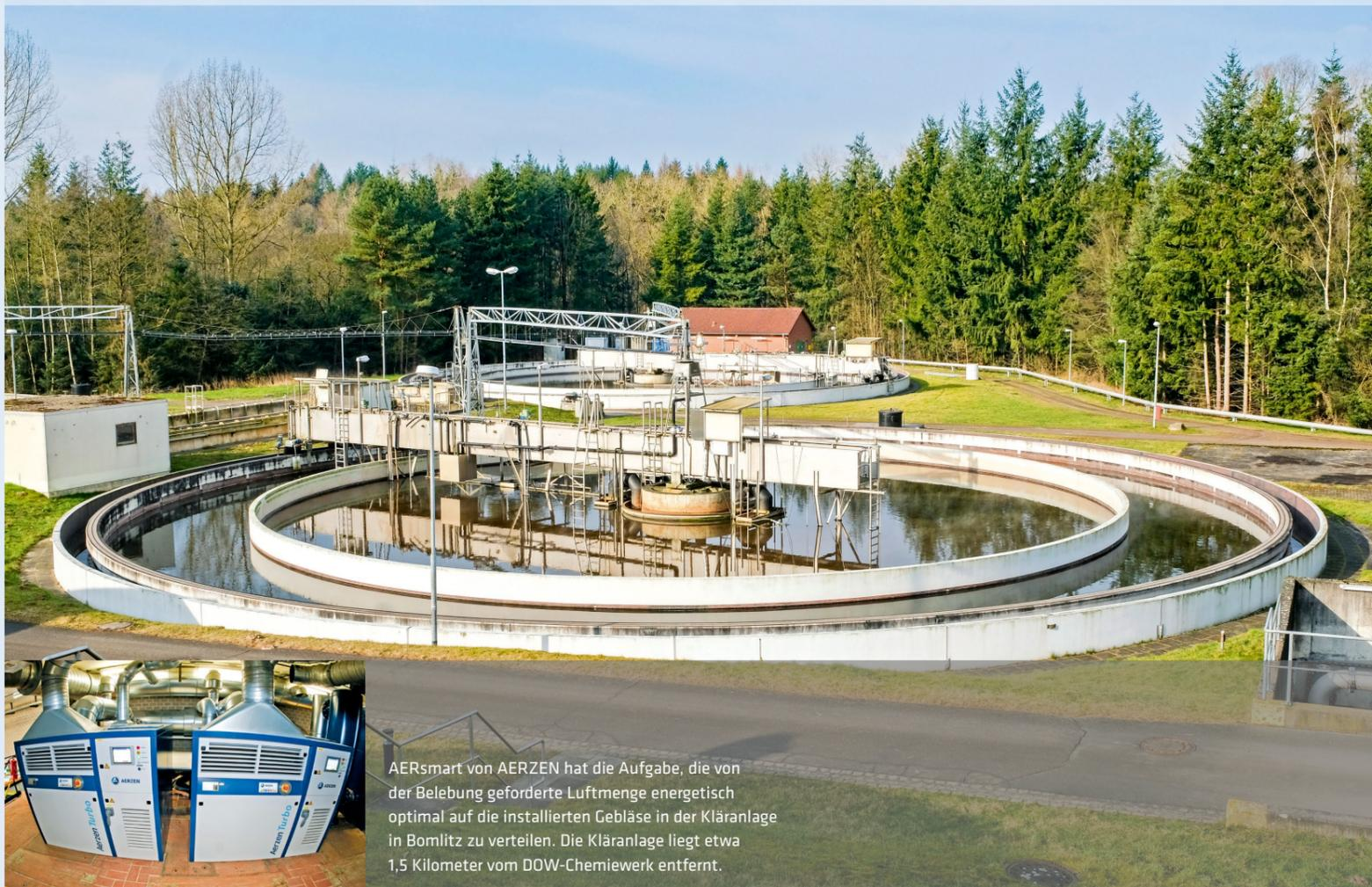
AERsmart von AERZEN hat die Aufgabe, die von der Belüftung geforderte Luftmenge energetisch optimal auf die installierten Gebläse in der Kläranlage in Bomlitz zu verteilen. Die Kläranlage liegt etwa 1,5 Kilometer vom DOW-Chemiepark entfernt.
