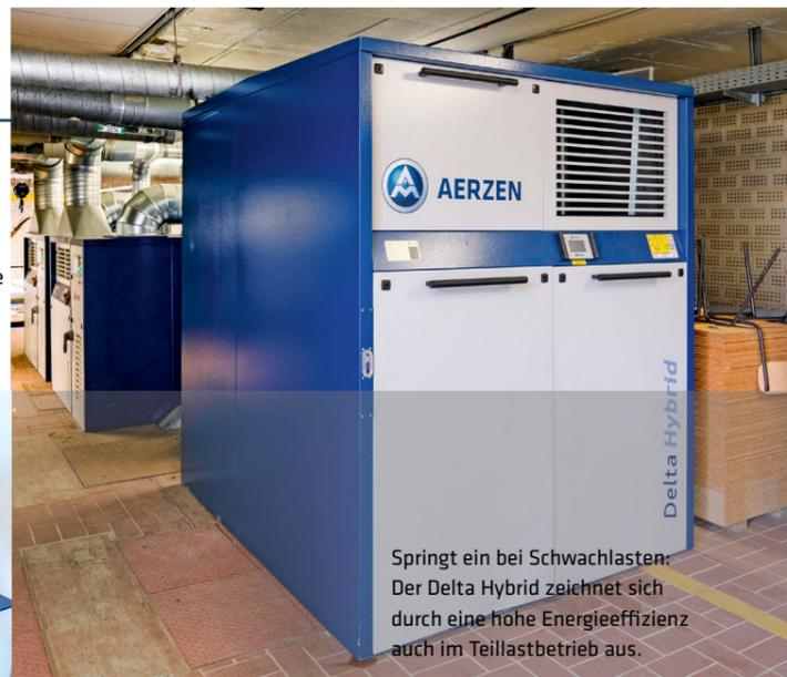
Springt ein bei Schwachlasten: Der Delta Hybrid zeichnet sich durch eine hohe Energieeffizienz auch im Teillastbetrieb aus.
