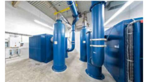
Schraubenverdichter von AERZEN sorgen bei JTI in Trier für perfekten Unterdruck.
