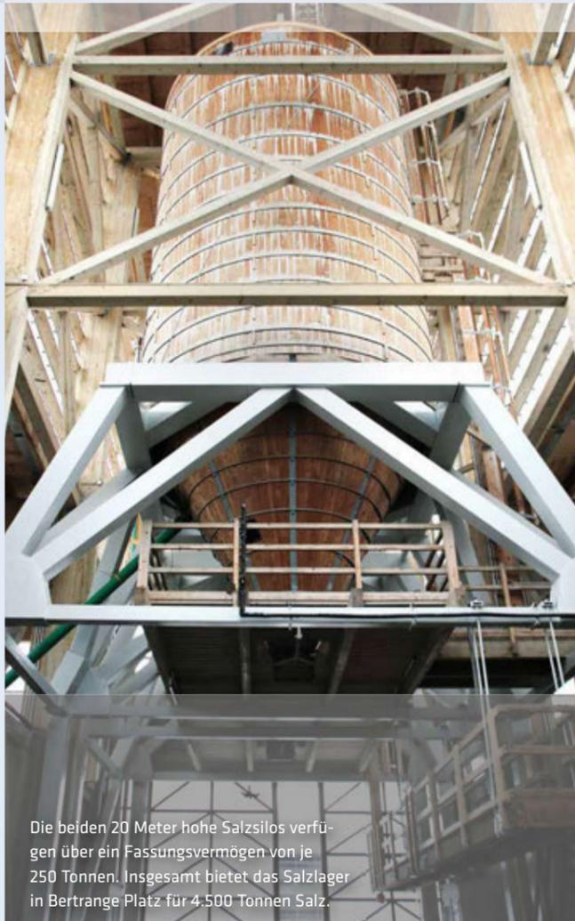
Die beiden 20 Meter hohe Salzsilos verfügen über ein Fassungsvermögen von je 250 Tonnen. Insgesamt bietet das Salzlager in Bertrange Platz für 4.500 Tonnen Salz.
