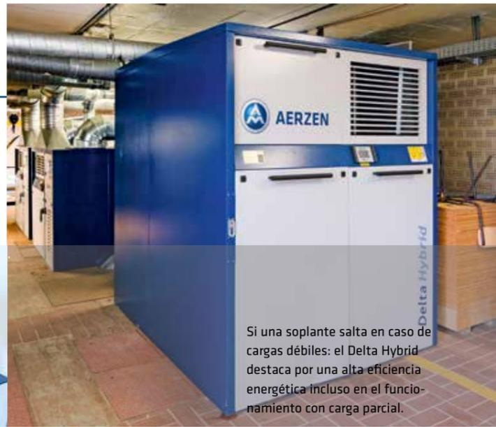
Si una soplante salta en caso de cargas débiles: el Delta Hybrid destaca por una alta eficiencia energética incluso en el funcionamiento con carga parcial.
