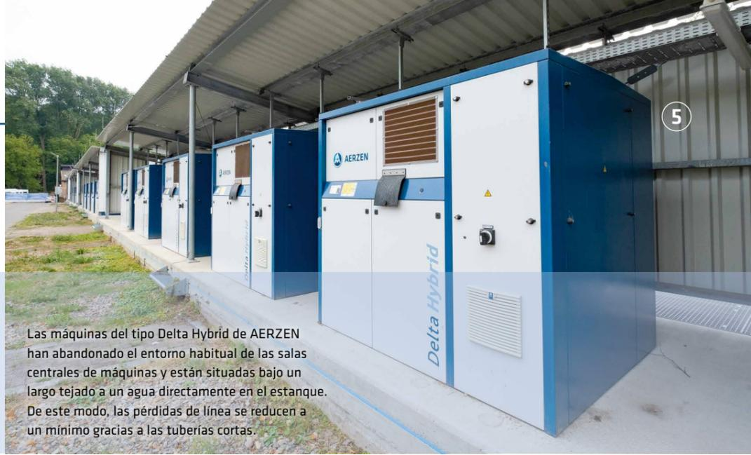
Las máquinas del tipo Delta Hybrid de AERZEN han abandonado el entorno habitual de las salas centrales de máquinas y están situadas bajo un largo tejado a un agua directamente en el estanque. De este modo, las pérdidas de línea se reducen a un mínimo gracias a las tuberías cortas.
