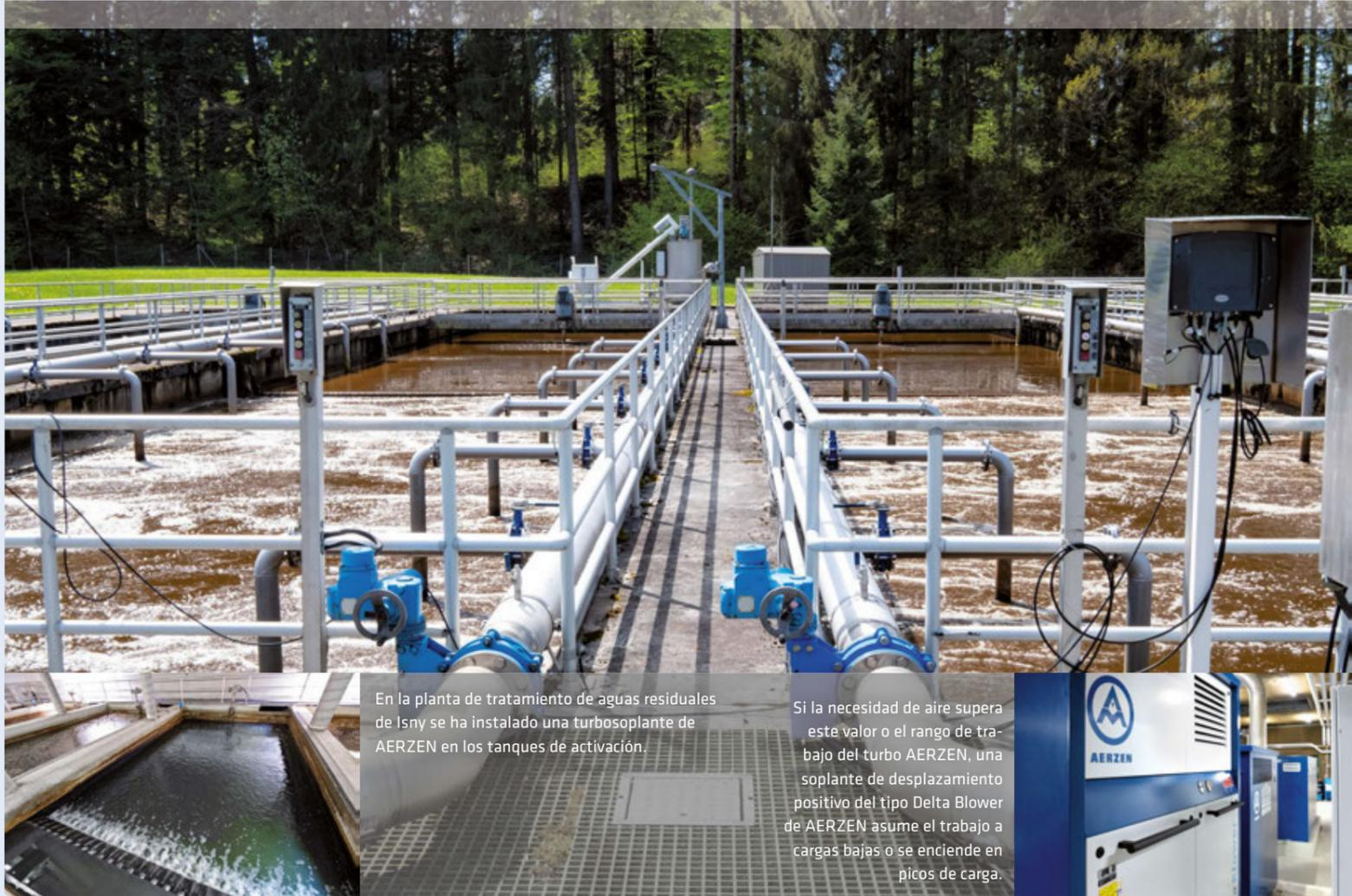
En la planta de tratamiento de aguas residuales de Isny se ha instalado una turbosoplante de AERZEN en los tanques de activación.
