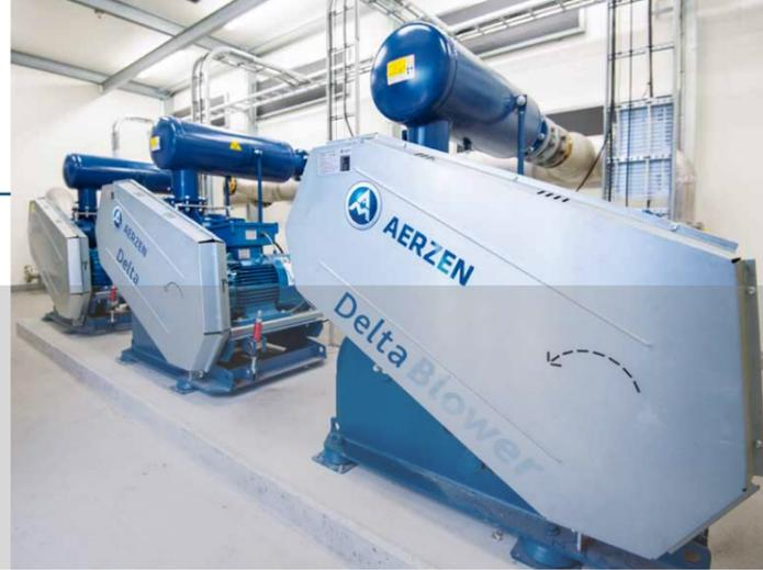
Una combinación de soplantes de émbolos rotativos de AERZEN del tipo Delta Blower se encarga de suministrar gas en una planta de producción de Arla. Las etapas de soplante son sistemáticamente iguales en términos de estandarización.
