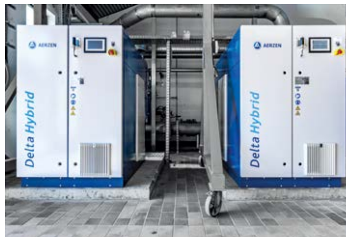
Delta Hybrid charakteryzuje się bardzo energooszczędną pracą i szerokim zakresem regulacji. Pozwala to na dostosowanie ilości tlenu do wahań obciążenia w oczyszczalni ścieków Unterföhring, w zależności od potrzeb.
