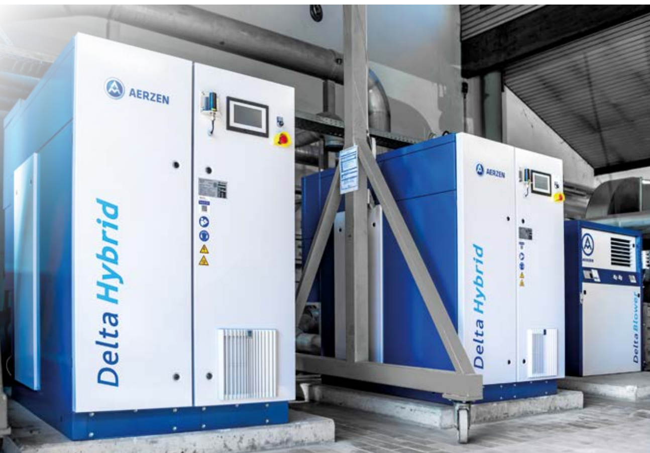
Dwie dmuchawy śrubowe AERZEN Delta Hybrid D315 z napędem bezpośrednim dostarczają tlen do zbiorników napowietrzających. Dmuchawa rotacyjna Delta Blower GM25S pełni funkcję maszyny rezerwowej.
