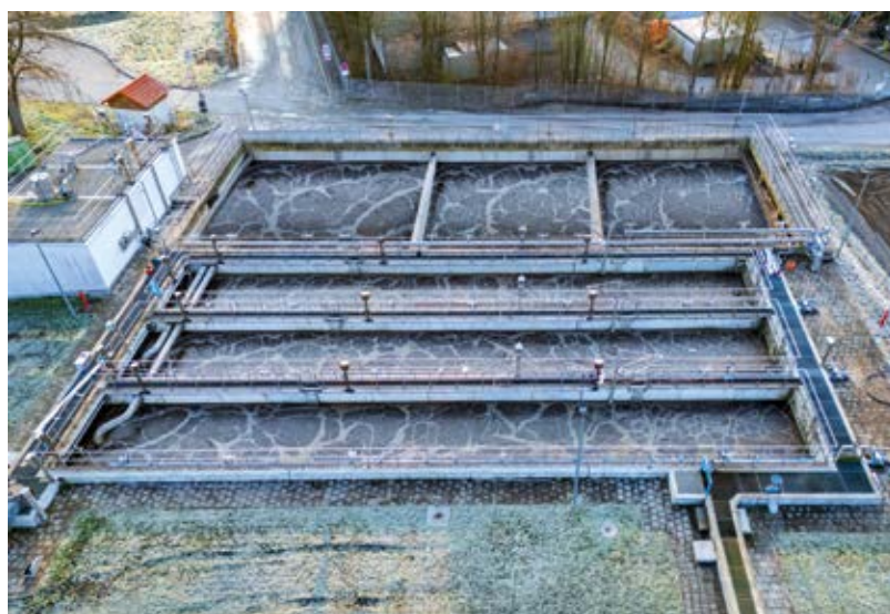
Biologiczny etap oczyszczania obejmuje dwa zbiorniki napowietrzania. Pierwszy - przepływowy w trzech kaskadach połączonych szeregowo, drugi - podzielony na trzy kanały pracujące równolegle.
