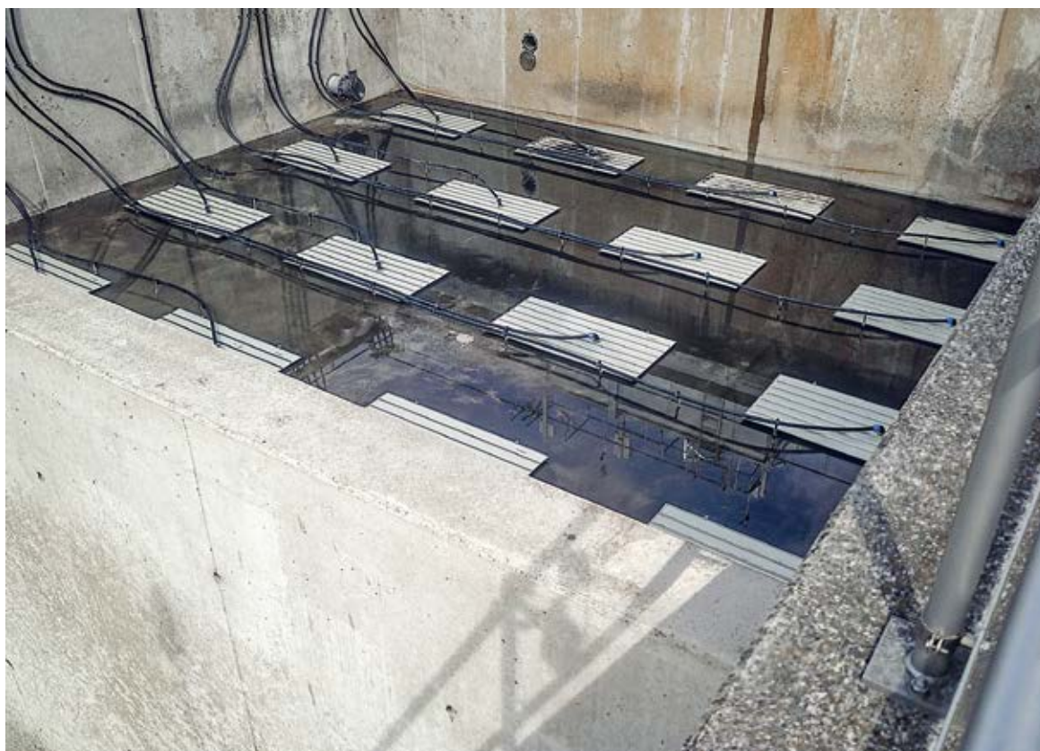
Montaż płyt napowietrzających MESSNER®
